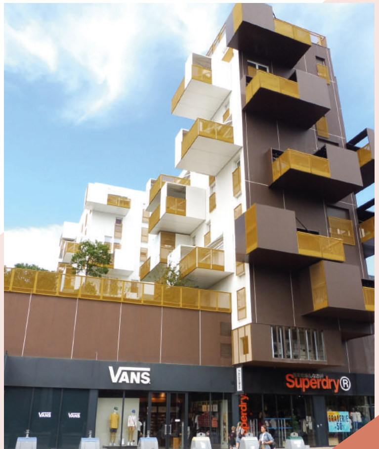
Façade de l'opération depuis l'avenue de l'Université ©audat.var
