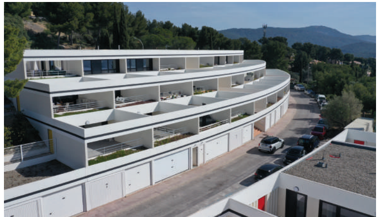
Effet gradin du bâti : box de stationnement en rez-de-chaussées, terrasses et logements du R+1 à R+3 ©Mise en boîte production
