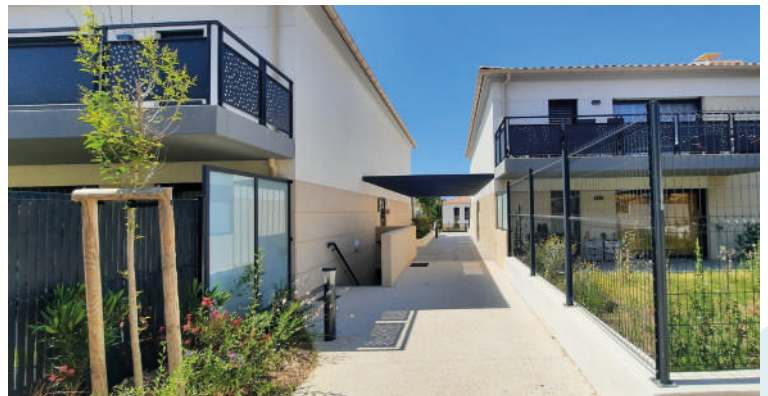
Entrée piétonne du bâti ©audat.var
