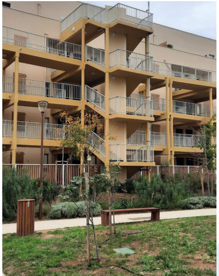
Desserte des appartements par coursives extérieures orientées au nord donnant sur la cour intérieure végétalisée © audat.var
