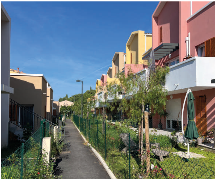
Venelle d'accès vers les logements ©Frédéric Pasqualini architecte
