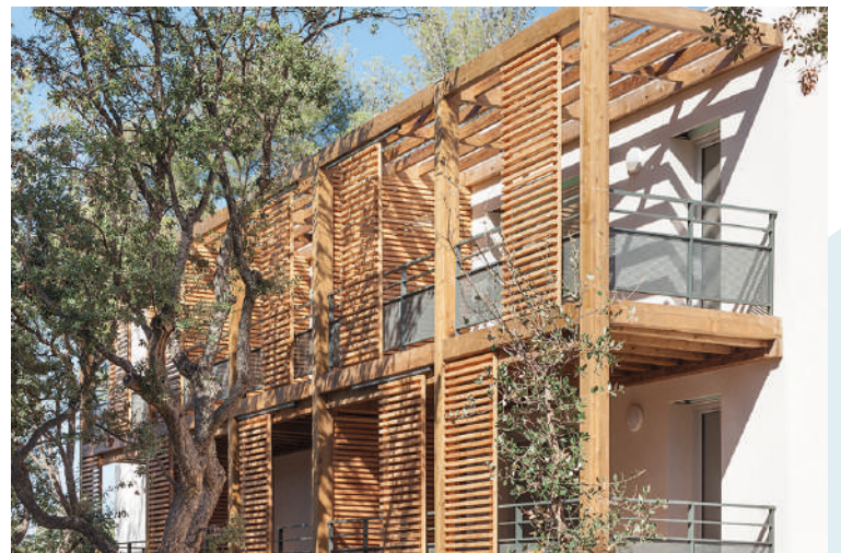
Brisés-soleil verticaux et horizontaux sur les terrasses. ©atelier empreinte
