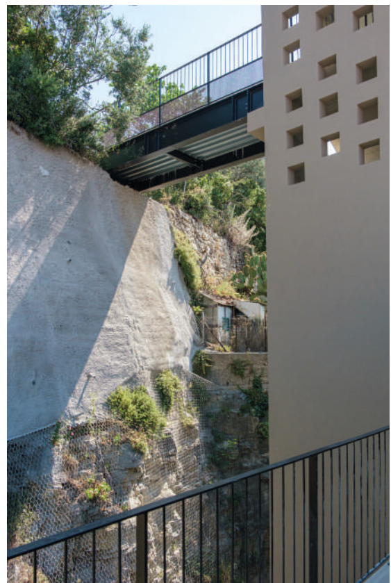
Tour raccordant la partie basse et haute du projet et passerelle piétonne haute ©Jean-Baptiste Reol
