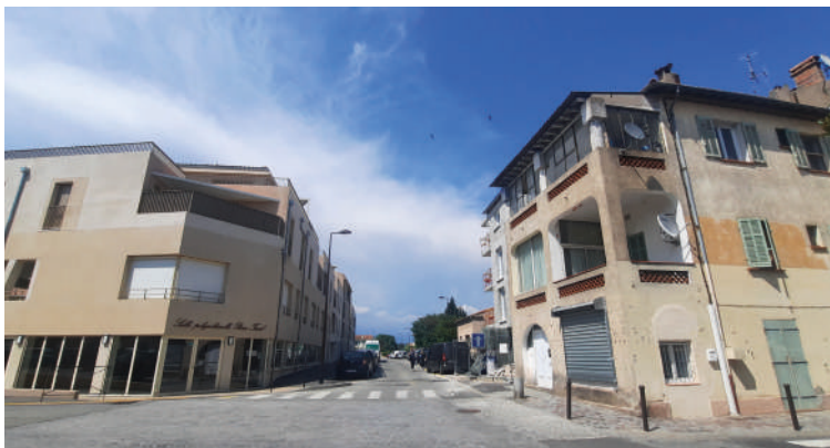
Façade sud de l'opération en dialogue avec le centre ancien ©audat.var
