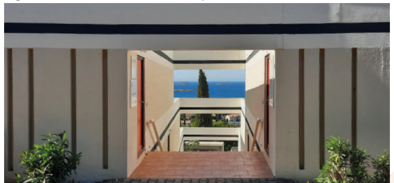
Vue depuis les escaliers d'accès aux logements ©audat.var
