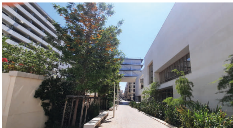
Cheminement piéton entre la Voile Blanche et la Médiathèque de Toulon ©audat.var
