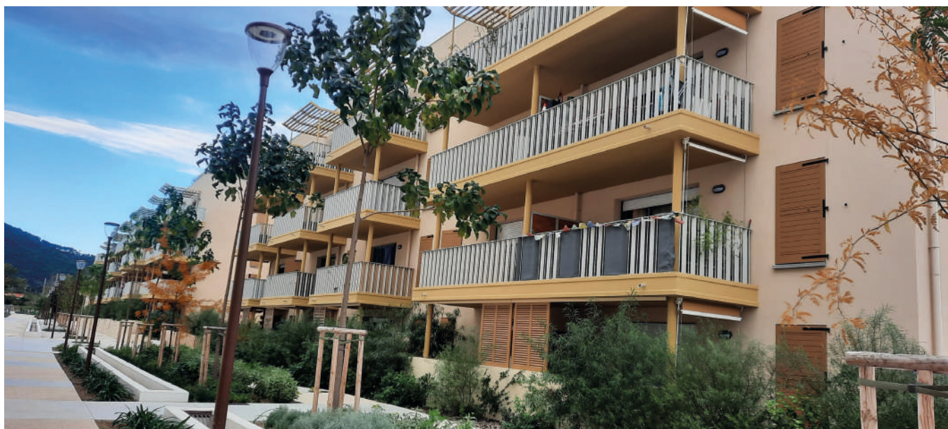
Façade des immeubles de l'îlot A sur le mail central de l'écoquartier © audat.var
