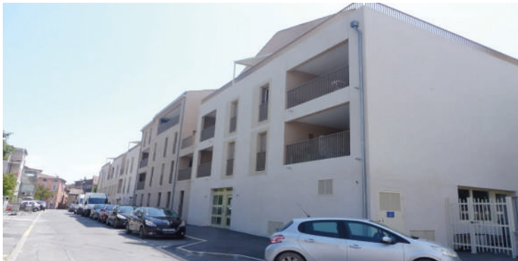
Façade depuis la rue Jules Ferry apres projet ©audat.var
