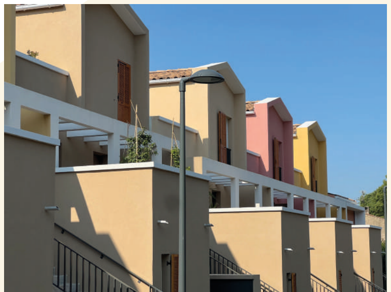
Brise-soleil verticaux sur les coursives ouvertes ©Frédéric Pasqualini architecte
