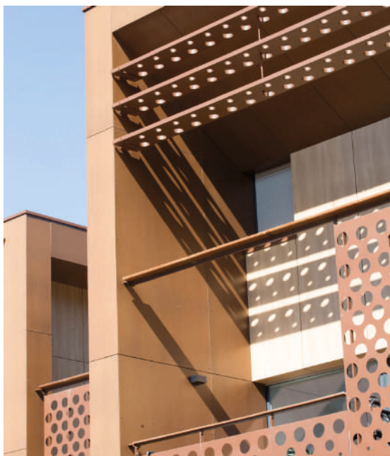
Brises-soleil sur les terrasses. ©C+B Architectes
