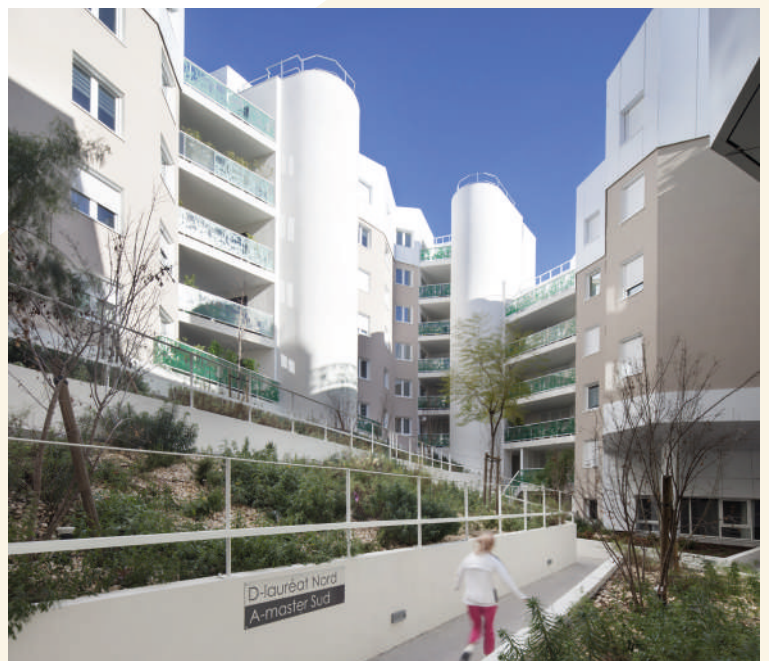
Jardin sur dalle en gradin qui accompagne la topographie du terrain ©Agence Jérôme Siame Architectes
