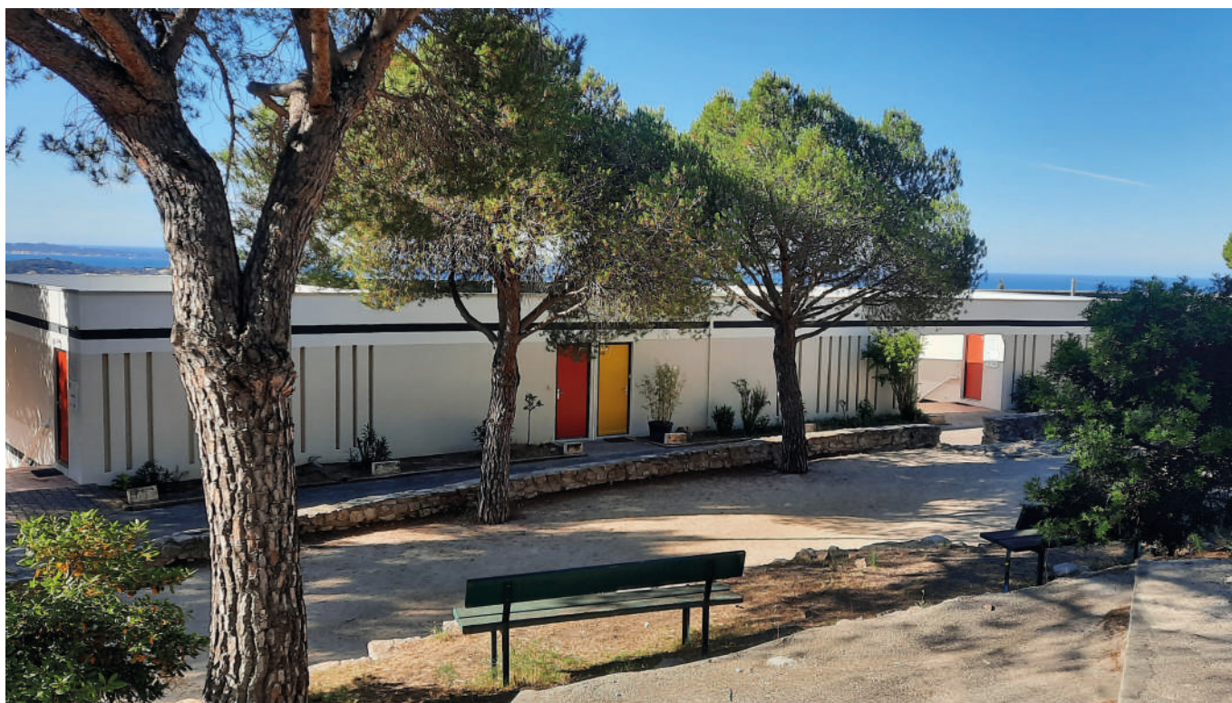
Vue depuis le nord de l'opération : terrain de pétanque avec des bancs, les entrées indépendantes à chaque logement du premier linéaire bâti ©audat.var
