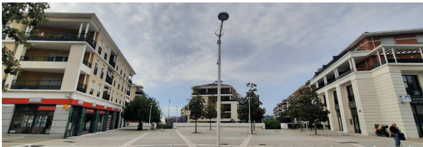
Vue de la Place de Vignes depuis l'Avenue Colonel Picot (nord du projet) ©audat.var
