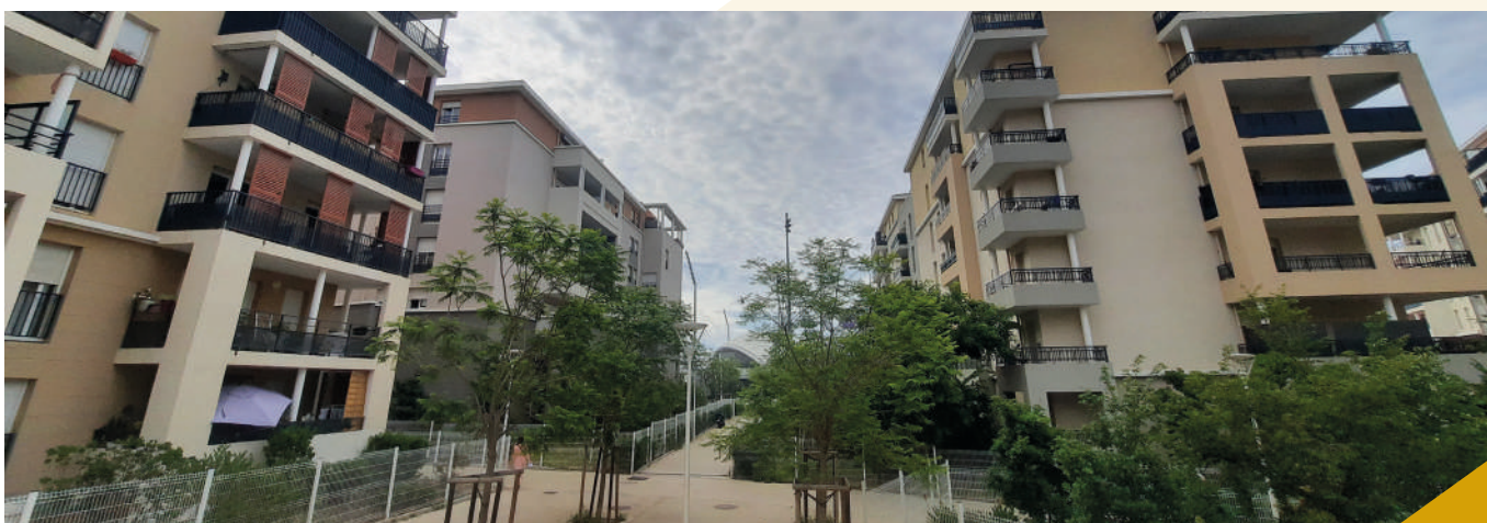
Vue intérieure de l'opération au niveau d'une traversée piétonne ©audat.var
