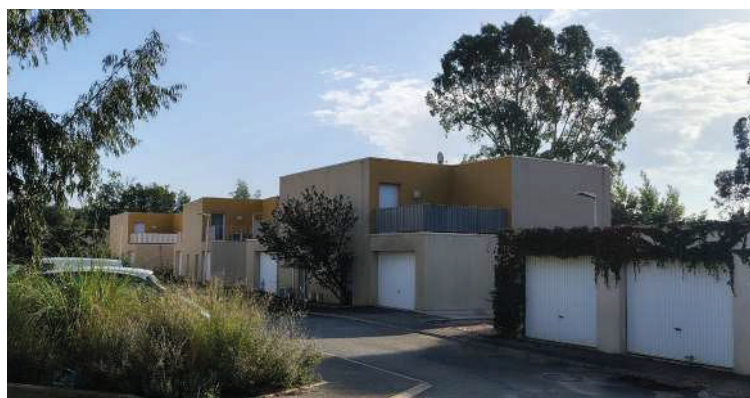
Vue depuis l'entrée de la rue d'Anicet vers les maisons individuelles et deux box de parkings dédiés aux petits collectifs. ©audat.var
