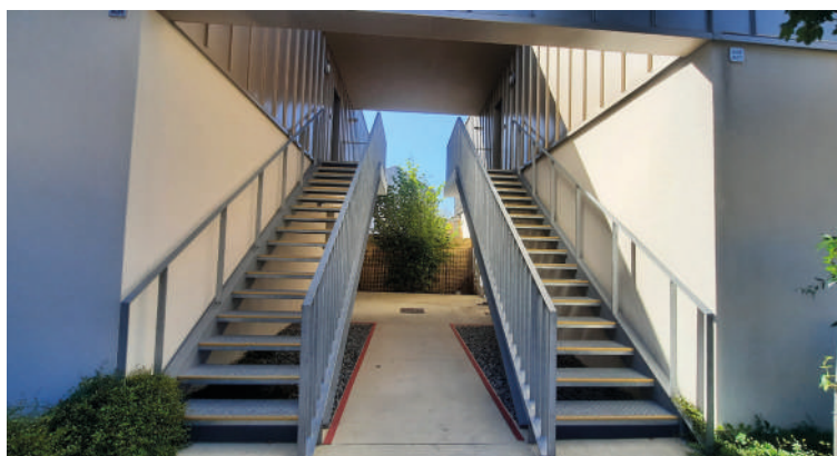
Desserte des logements en R+1 par des escaliers extérieurs. ©audat.var
