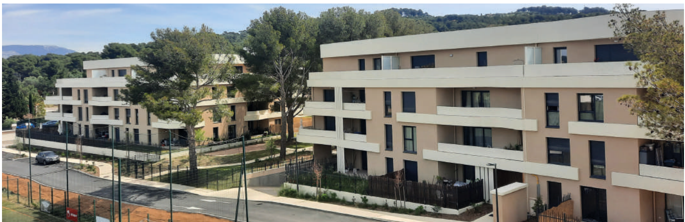
Vue de la façade principale de l'opération à la lisière de l'équipement sportif © audat.var
