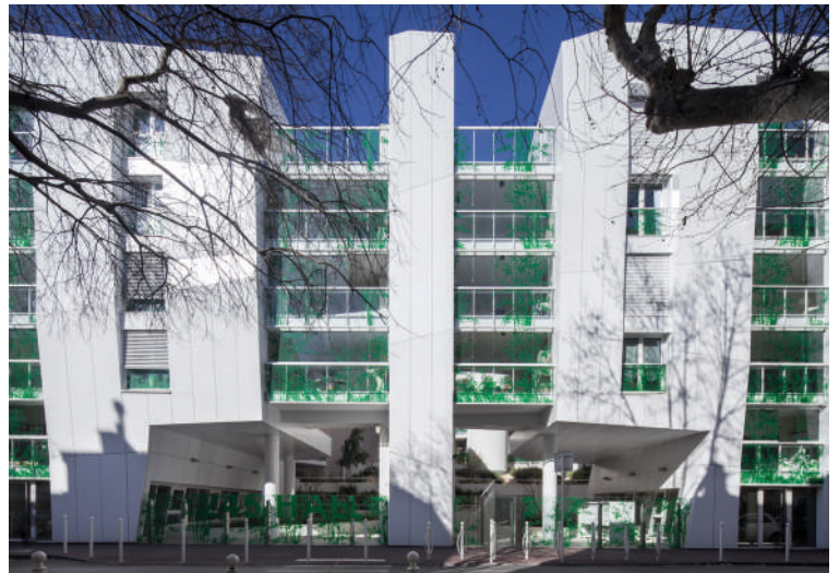
Vue de l'entrée de l'opération et des locaux vélos sur l'avenue François Cuzin ©Agence Jérôme Siame
