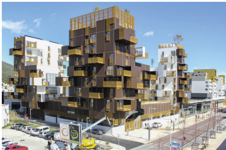
Vue de l'opération depuis le centre commercial ©SPL Méditerranée
