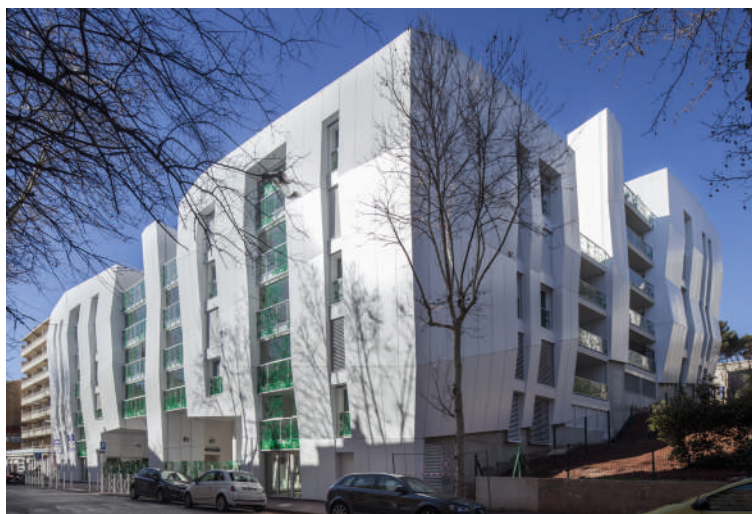
Vue de l'entrée de l'opération depuis l'avenue François Cuzin ©Agence Jérôme Siame Architectes
