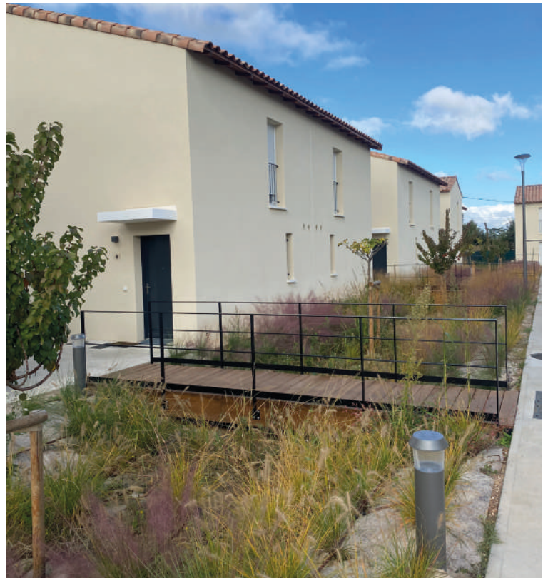
Noues paysagères permettant de capter l'eau pluviale des toitures ©Atelier Pirollet Architectes
