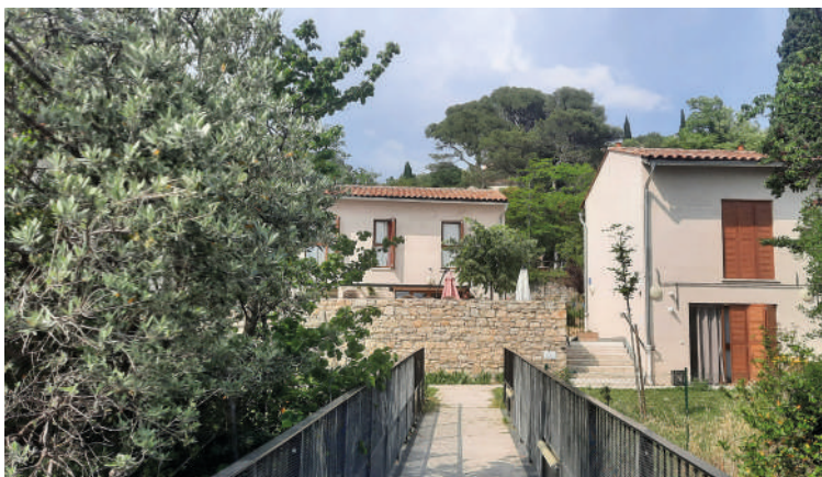
Vue depuis la passerelle vers les logements de la partie haute de l'opération ©audat.var
