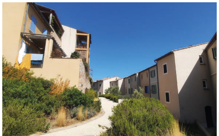
Voie piétonne entre les bâtis ©audat.var
