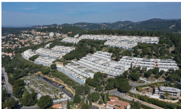
Intégration de l'ensemble de l'opération sur la colline à Bandol ©Mise en boîte production
