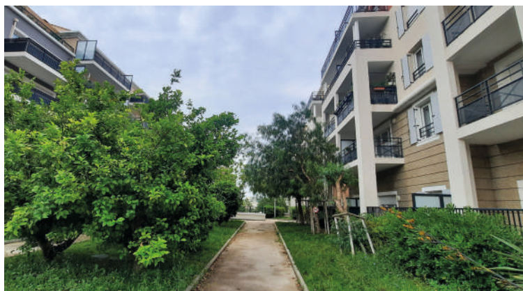
Végétation intégrée à l'opération pour favoriser le confort thermique et servir de barrière visuelle pour les appartements du rez-de-chaussée ©audat.var
