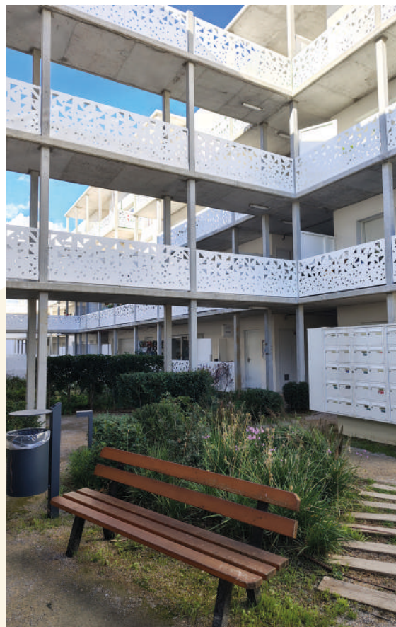
Première espace de repos de l'opération, avec son cheminement menant vers les boîtes aux lettres et la conciergerie en fond. À l'étage, une entrée indépendante permet d'accéder à un logement depuis le balcon. ©audat.var
