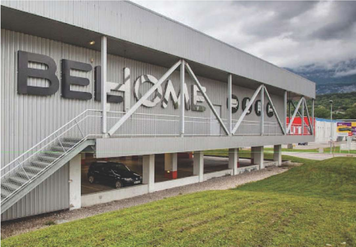
Bâtiment commercial Belhome, Voglans, Savoie
