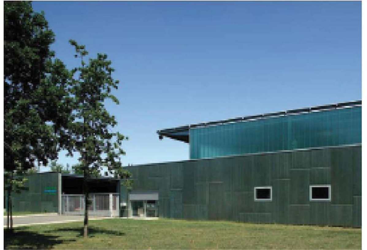
Centre technique municipal, la Chapelle sur Erdre
