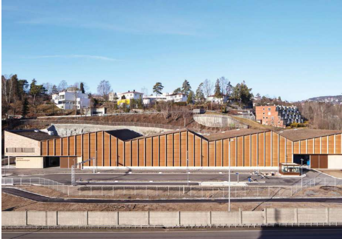
Centre de recyclage, Suède
