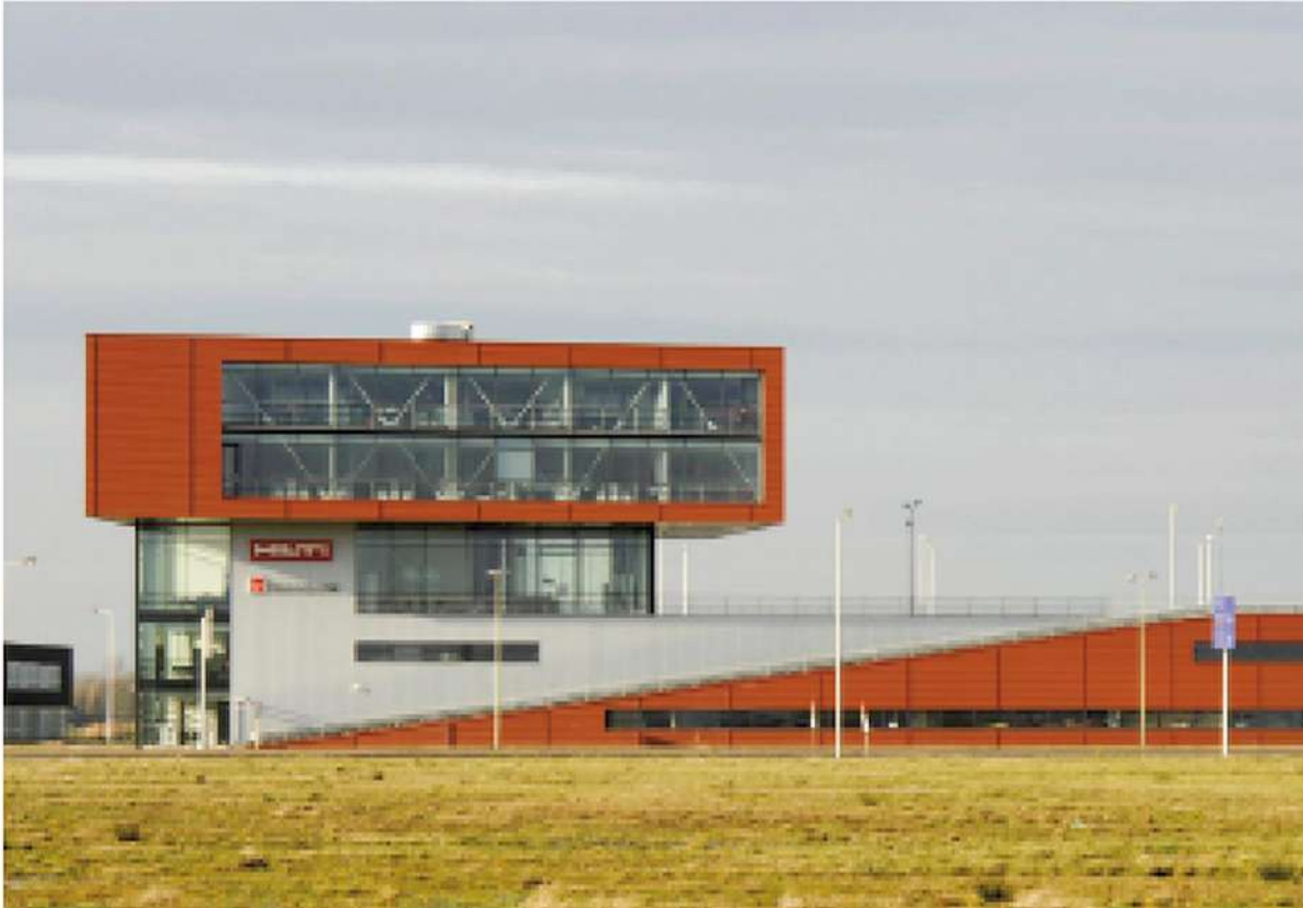
Bâtiment Hilti, Pays-Bas
