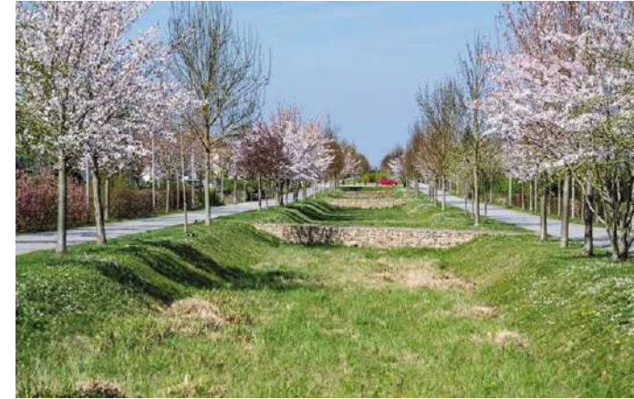
Bassin de rétention
