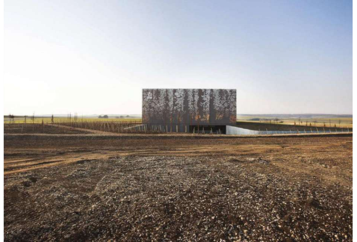
Stockage EDF, Bures
