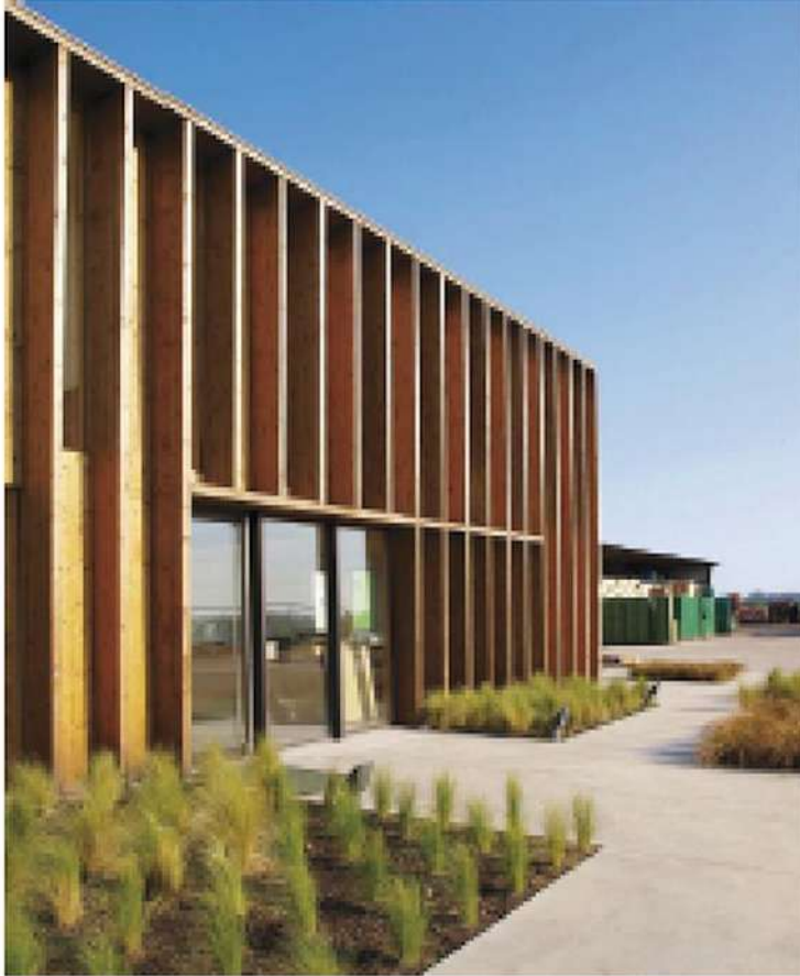
Bâtiment Hilti, Pays-Bas
