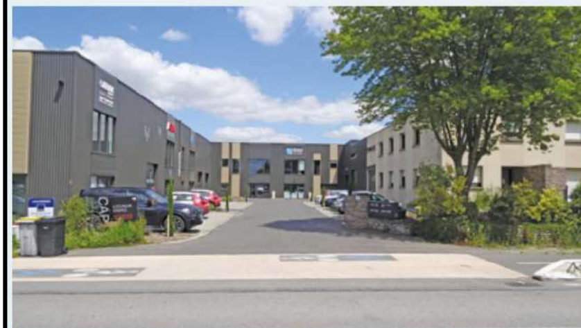
ZA la Hallerais, Vern-sur-Seiche. Extension d'un bâtiment existant. Crédit : © Audiar.
