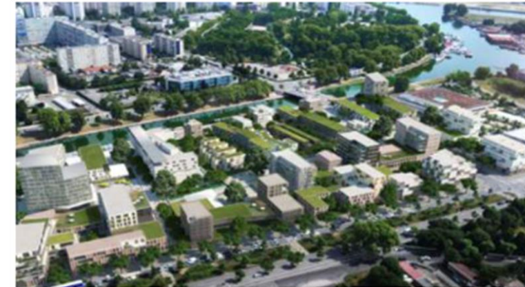
Réaménagement de l'écoquartier Danube à Strasbourg, ASPA, crédit : Agence Platform
